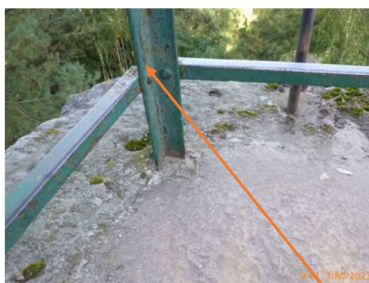
Kotvení zábradlí na vrcholu vyhlídky
